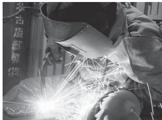
アーク溶接作業（溶接基本実習）
