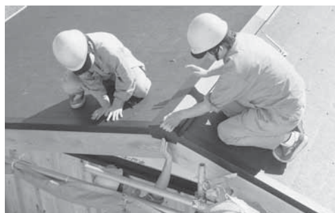
金属屋根施工実習
