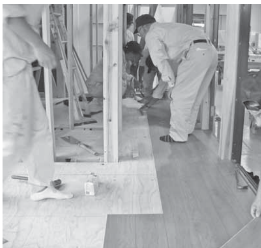
建築施工実習
